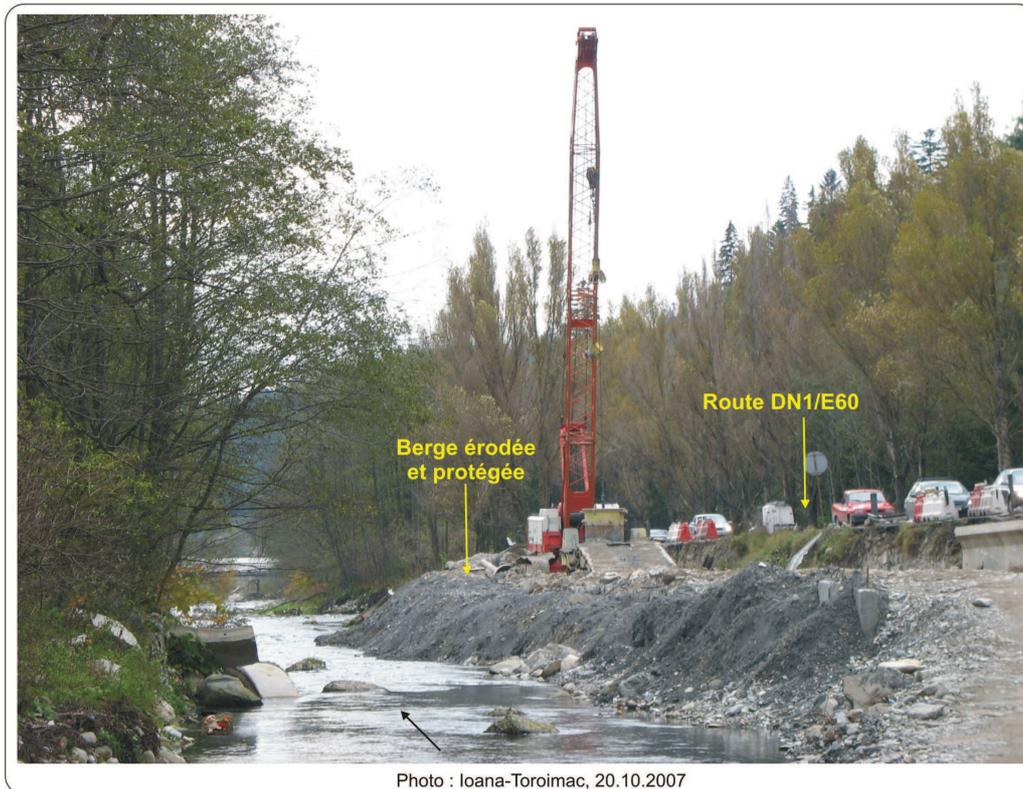
**Photo 1. Renforcement de la berge droite de la Prahova, suite à l'écroulement de la route DN1/E60. La photo montre également le trafic intense sur cet axe de transport.**
