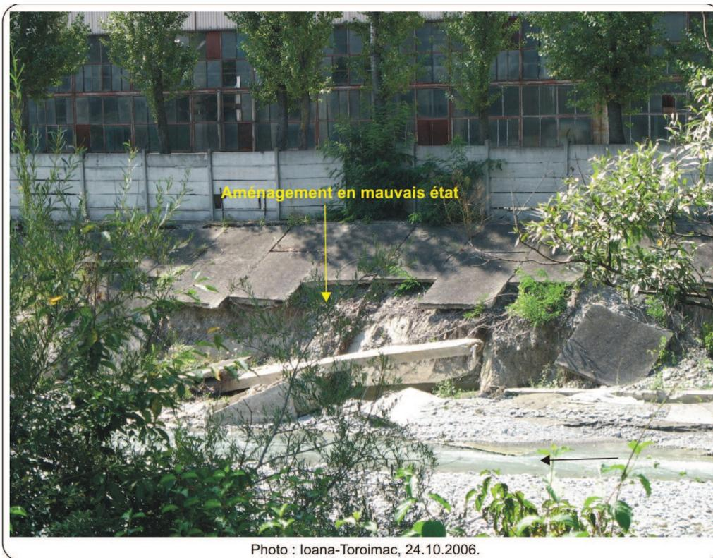
**Photo 8. Aménagement en mauvais état à Poiana Câmpina. Cet aménagement a le rôle de protéger contre les inondations la zone industrielle qui se trouve sur la rive droite de la Prahova.**
