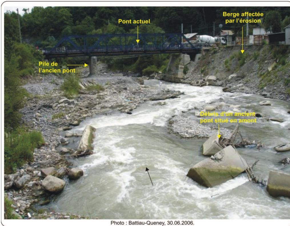
**Photo 4. Le nouveau pont de type bailey traversant la Prahova à Posada. L'ancien pont s'est effondré comme effet de la dynamique de la rivière.**
