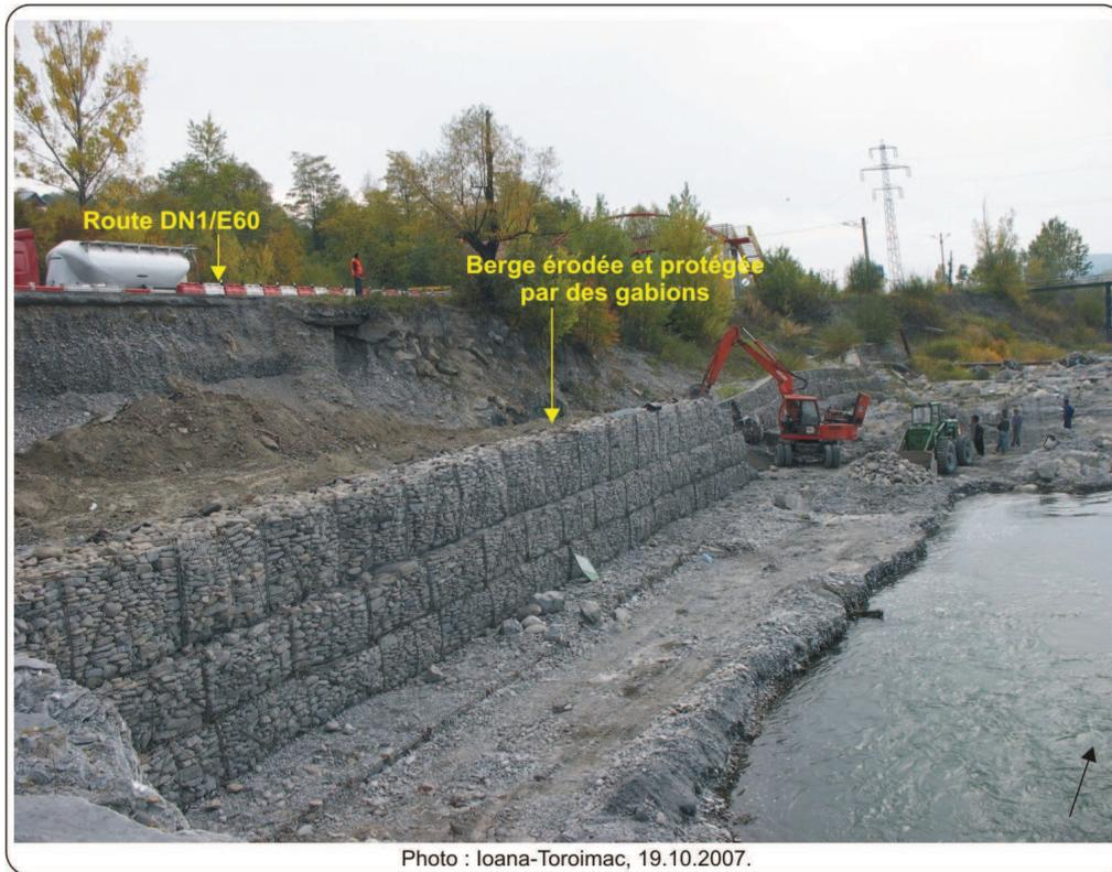
**Photo 3. Renforcement de la berge gauche de la Prahova à Breaza suite à l'écroulement de la route DN1/E60.**
