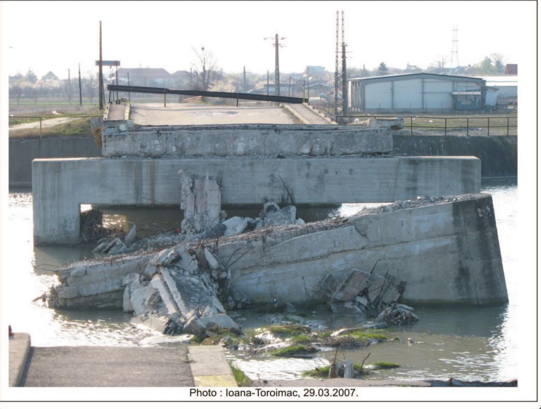
**Photo 6. Pont routier détruit et circulation empêchée entre les localités de Nedelea et de Filipeștii de Târg.**
