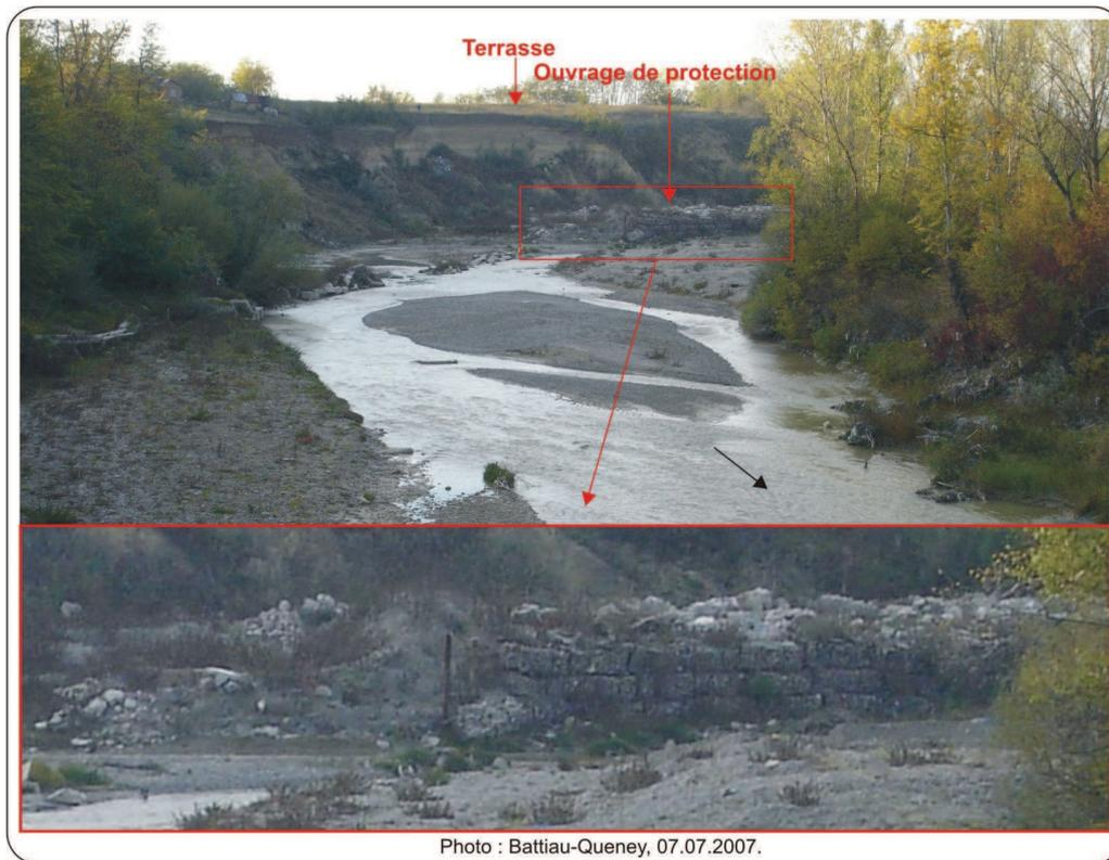
**Photo 10. Moyen de protection de la terrasse de Stejaru contre l'érosion latérale de la Prahova.**
