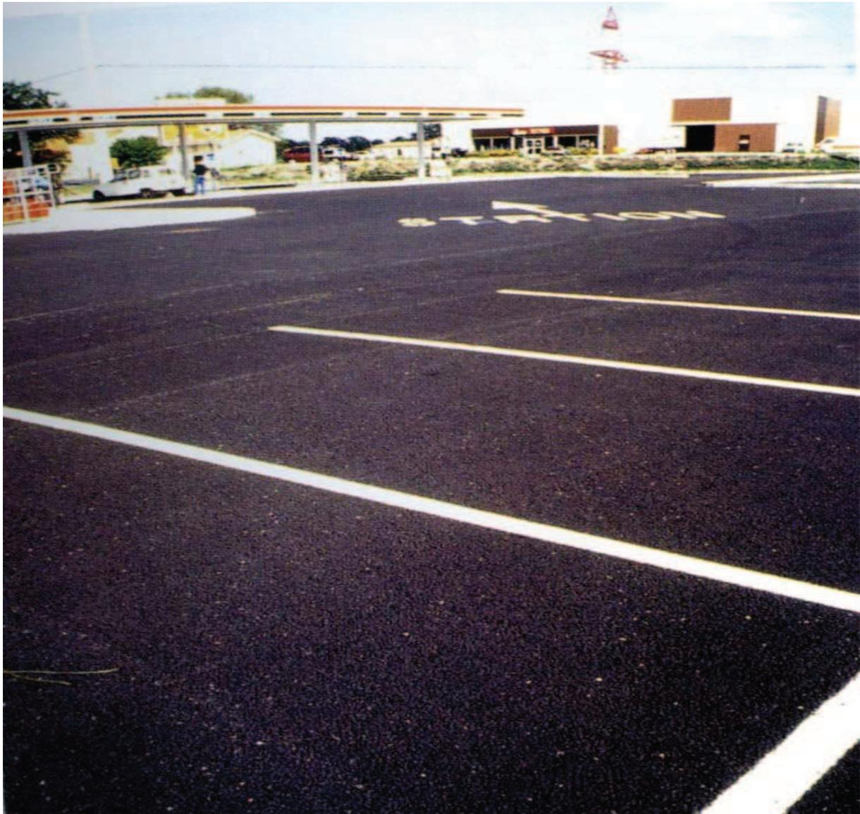
Figure 9 : Chaussée réservoir sur le site d'un supermarché. L'eau s'infiltré par le matériau drainant de surface puis elle est stockée dans la structure réservoir pour enfin être restituée progressivement dans le réseau aval. Source CETE Sud-Ouest.
