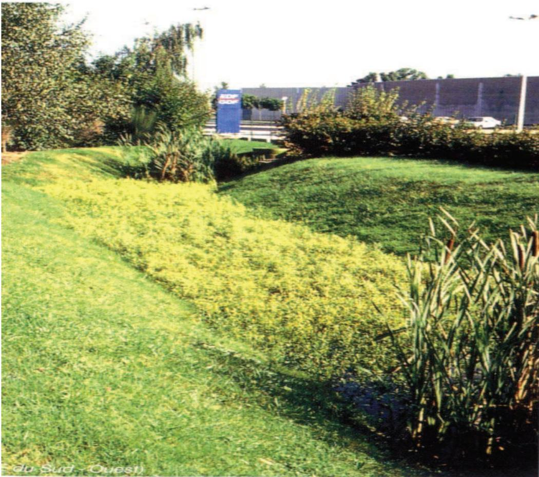
Figure 16 : Noue peu profonde avec des rives en pente douce. Sa fonction principale est le stockage des eaux pluviales. Le stockage et l'écoulement de l'eau se font à l'air libre, à l'intérieur de la noue. Source, CETE Sud-Ouest.
