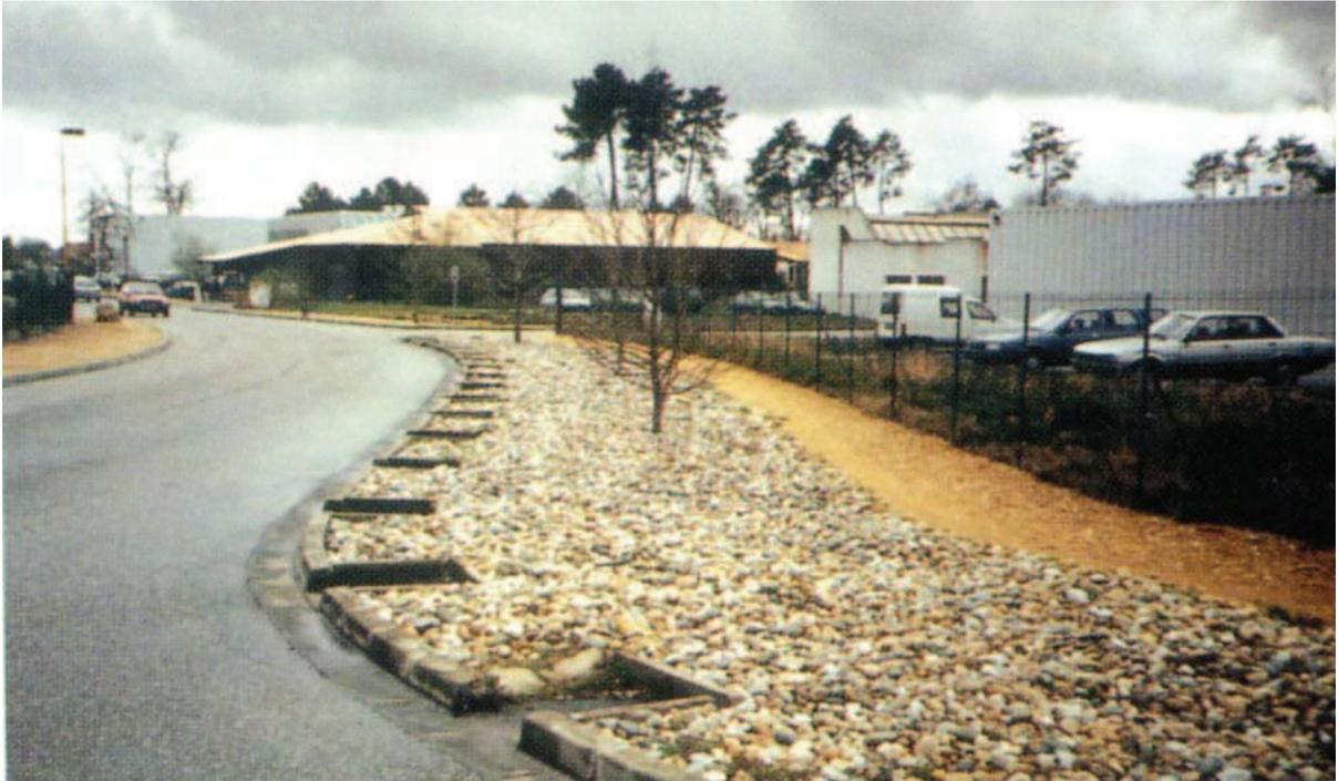
Figure 21 : La tranchée sert à retenir les eaux puis à les évacuer soit par infiltration, soit vers un exutoire (réseau, puits, etc.). Elle peut revêtir différents matériaux de surface (minéral ou végétal). Ici la tranchée est revêtue de galets. Source CETE Sud-Ouest.
