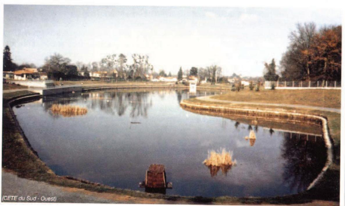
Figure 1 : Bassin en eau régulant les écoulements d'un bassin versant de 2300ha. Profond d'un à deux mètres, il stocke près de 50000 m<sup>3</sup>. Il est utilisé pour la pêche (réserve écologique) et la promenade. Source CETE du Sud-Ouest.
