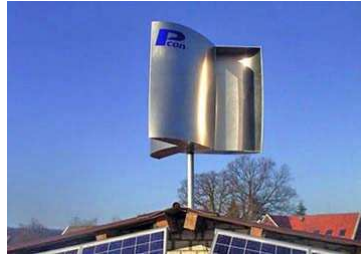
Figure I.4 – Eolienne Savonius sur une toiture [Lar 09]
