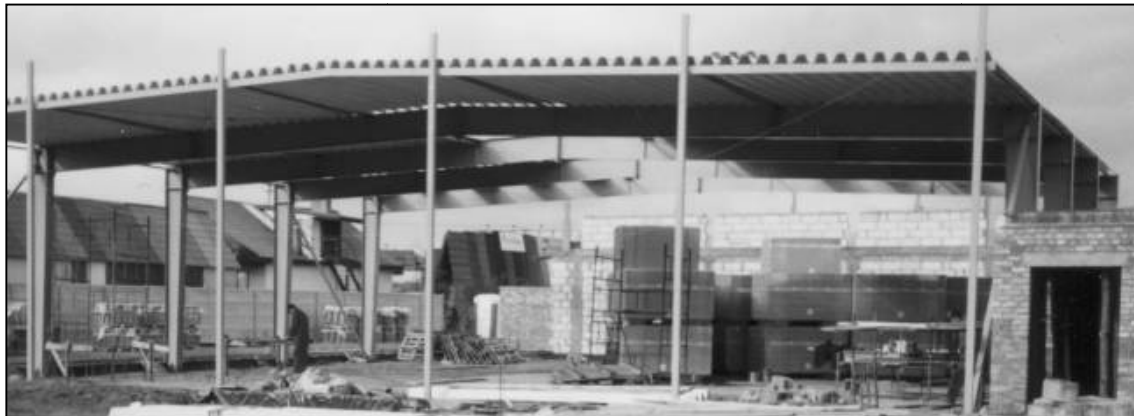
Rys. 2.1 Przykładowa konstrukcja parterowej ramy portalowej
