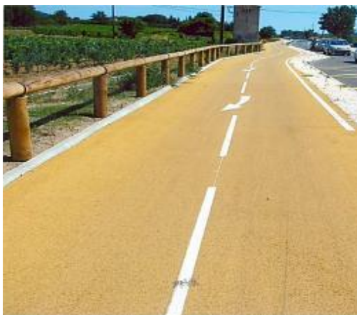
Figure I.40. pistes cyclables à l'asphalte coulé [74]
