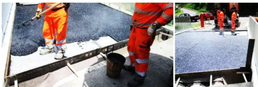
Figure IV.2 Application de l'asphalte coulé dans les ponts
