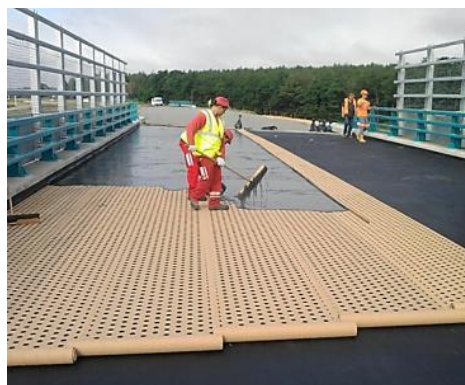
Figure I.34. Asphalte coulé dans le tablier du pont[71]
