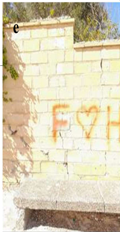
Figure 65 : Fissures de décompression relevées sur le mur des habitations en haut du massif.
