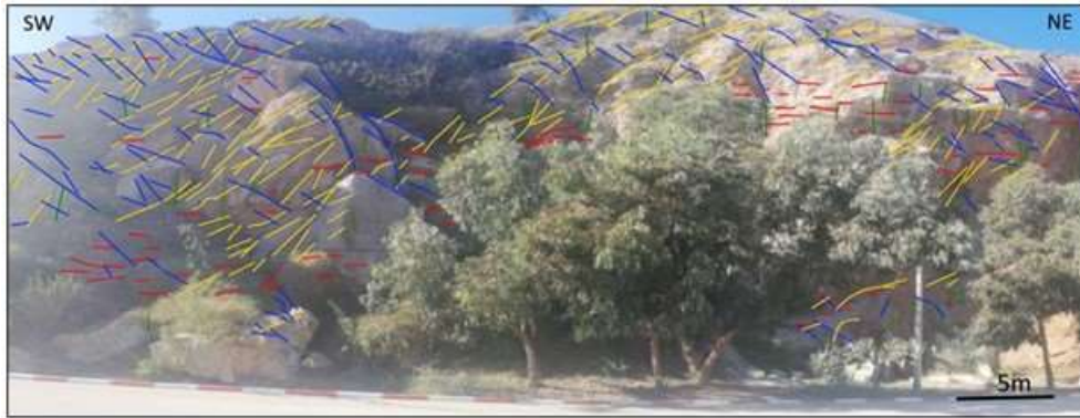
Figure 50-2 : Etat de la fracturation de la falaise de Quemado.
