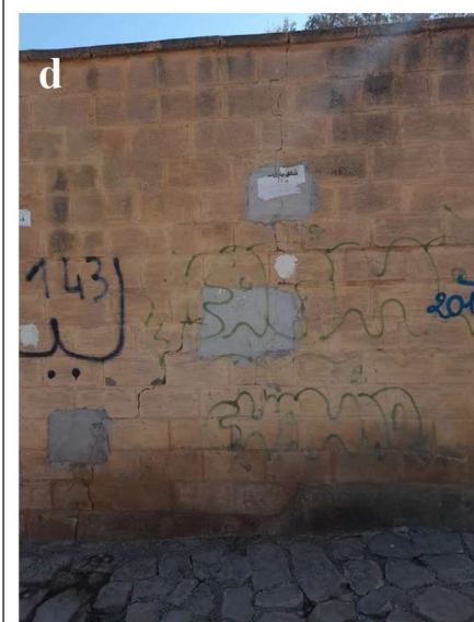
Figure 65 : Fissures de décompression relevées sur le mur des habitations en haut du massif.
