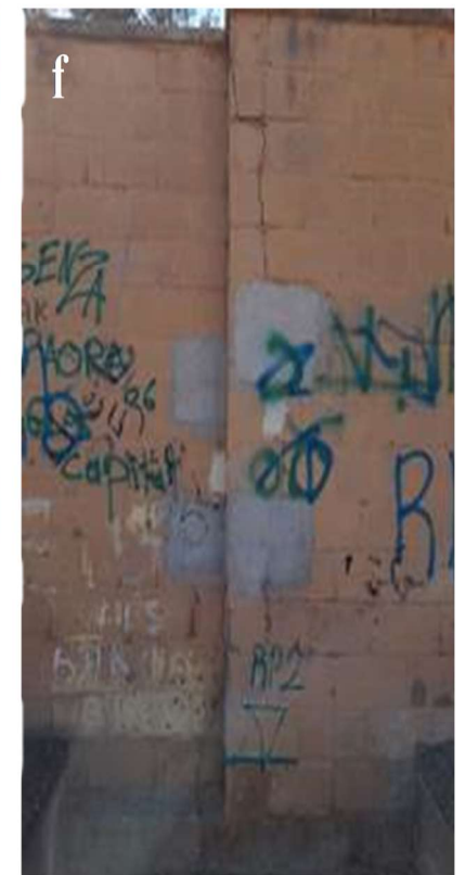
Figure 65 : Fissures de décompression relevées sur le mur des habitations en haut du massif.
