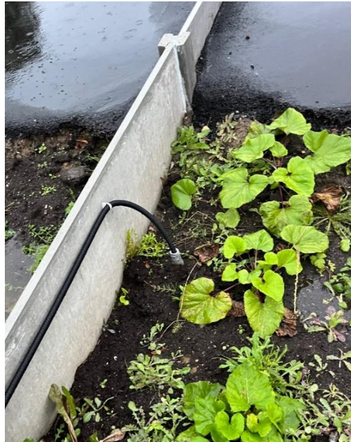
Figure 32 : Position du capteur de niveau d'eau
