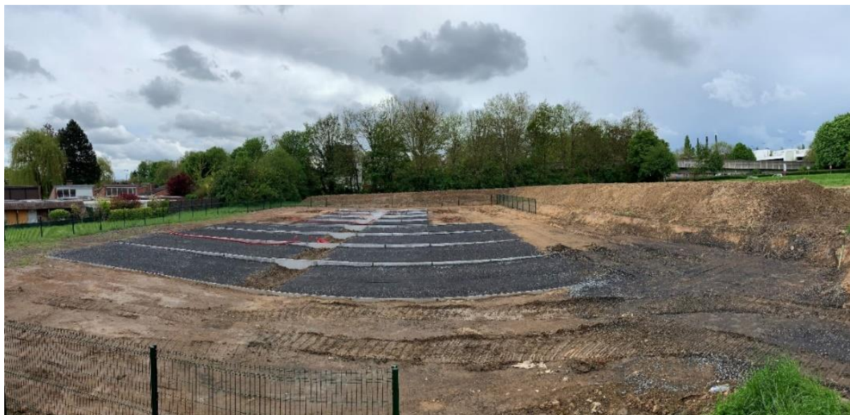
Figure 28 : Finalisation des travaux du site expérimental
