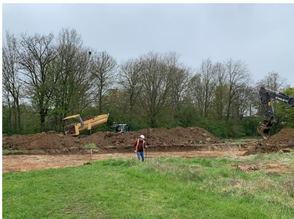
Figure 27 : Terrassement du site
