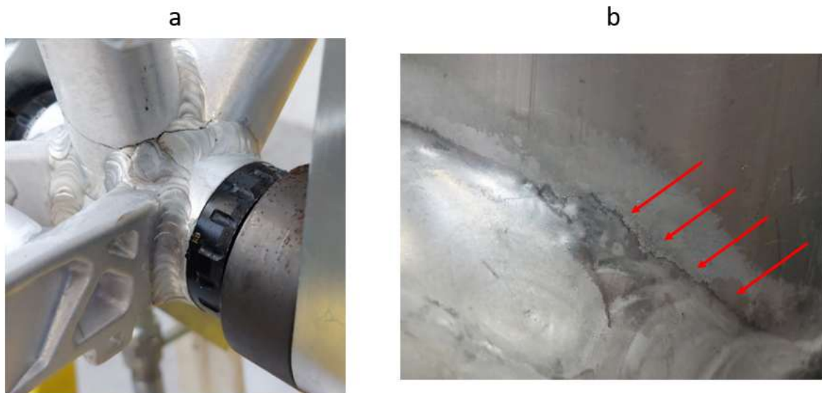
Figure 92 : Exemples de fissuration en pied de cordon, (a) au niveau du boîtier de pédalier et (b) sur une éprouvette soudée.
