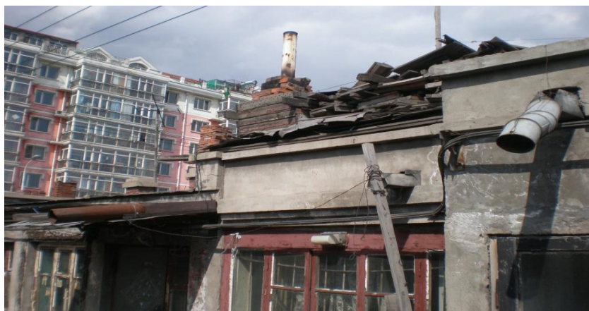
Matériaux déposés sur les toits pour protéger du froid
