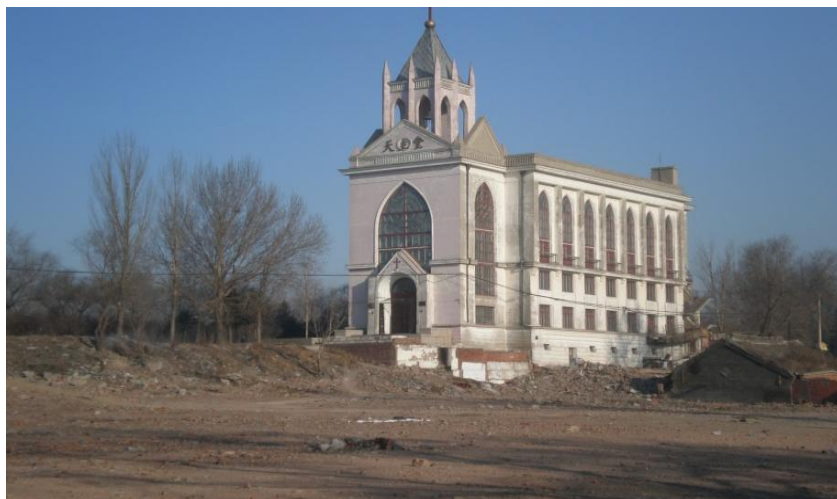
Eglise catholique du quartier Daowai
