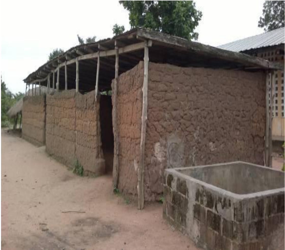
Photo 10 : École primaire de Bokokopé. Au premier plan, l'apatam construit en 2002 et derrière le nouveau bâtiment en dur obtenu avec l'appui d'une ONG et la participation de la communauté.
