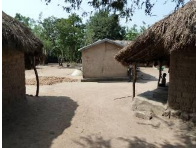
Photo 7 : Habitat typique à Bokokopé (2012). Il est composé de cases en terre couvertes de pailles. Les cases les plus améliorées sont couvertes de tôles ondulées, mais le bâtiment reste en terre.
