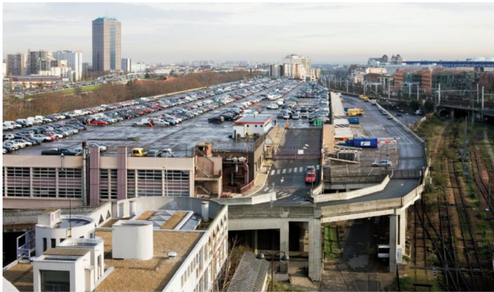
Toit de l'entrepôt Macdonald
