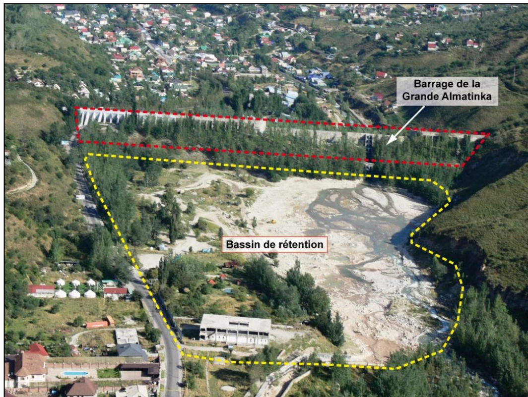
Figure 42: Le barrage sur la Grande Almatinka (vue de l'amont du torrent)
