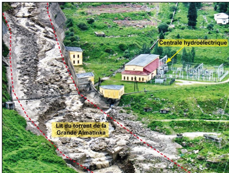
Figure 9: Les conséquences de la lave torrentielle du 6 juillet 2006 sur le torrent de la Grande Almatinka
