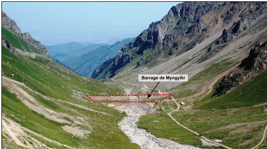
Figure 37: Le barrage de Myngylki sur le torrent de la Petite Almatinka (vue de l'amont du torrent)
