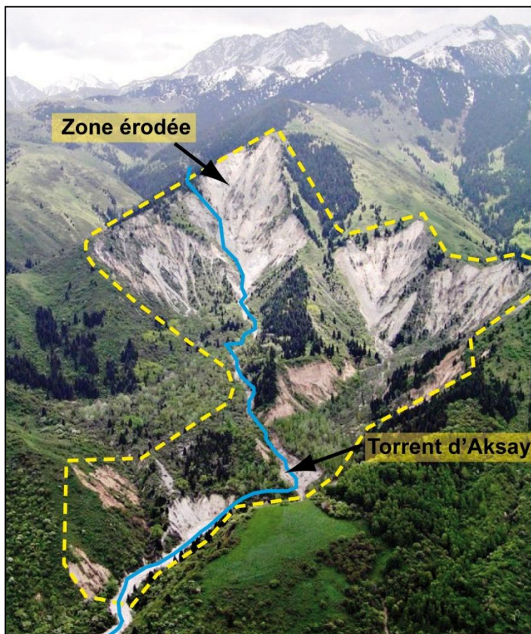
Figure 20: Une zone de déclenchement des glissements de terrain et des laves torrentielles d'origine sismique en vallée d'Aksay suite à la catastrophe de 1887
