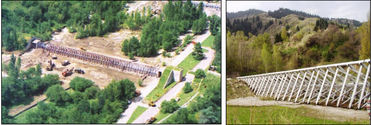
Figure 39: Les grilles métalliques de protection contre les laves torrentielles sur la Petite Almatinka
