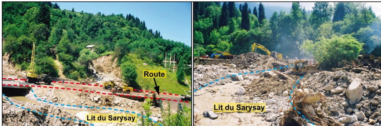
Figure 48 : Les dégâts causés par la lave torrentielle sur le torrent de Bedelbay du 14 juillet 1999
