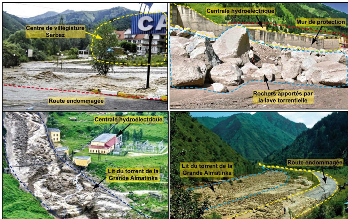
Figure 46: Les dégâts provoqués par la lave torrentielle de 2006 dans la vallée de la Grande Almatinka en amont du barrage
