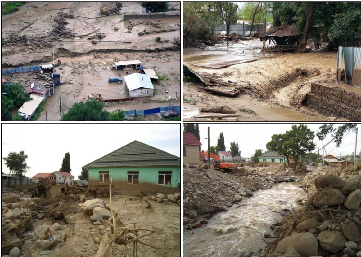
Figure 53: Les dégâts causés par la lave torrentielle en aval du barrage de Kargalinka
