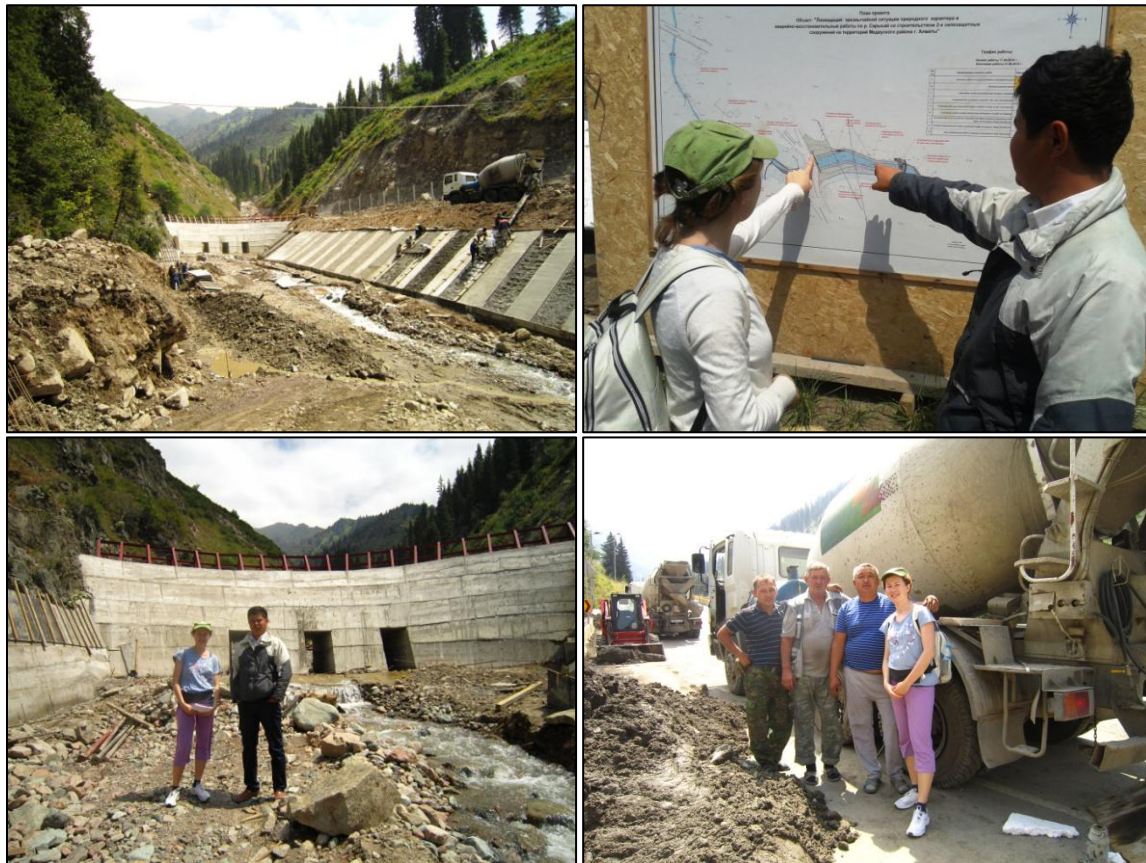
Figure 25: L'observation du nouveau barrage en construction sur le torrent de Sarysay le 30/07/2014
