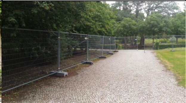
Photographie n° 109 : les grilles provisoires installées pour sécuriser le Tiergarten (vue sur le bassin de Vénus depuis l'ouest). Source : J. Gaquère, 21/06/2017
