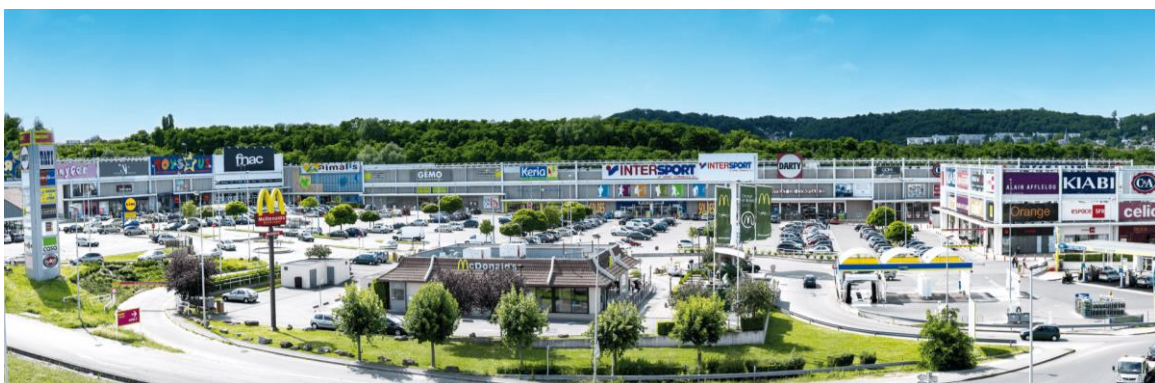
Figure 23. Villebon 2, le premier retail park de France, avant sa dernière rénovation, avec 47 500 m 2 de surfaces commerciales, 45 magasins et 1 850 places de parking. Source : frey.fr.
