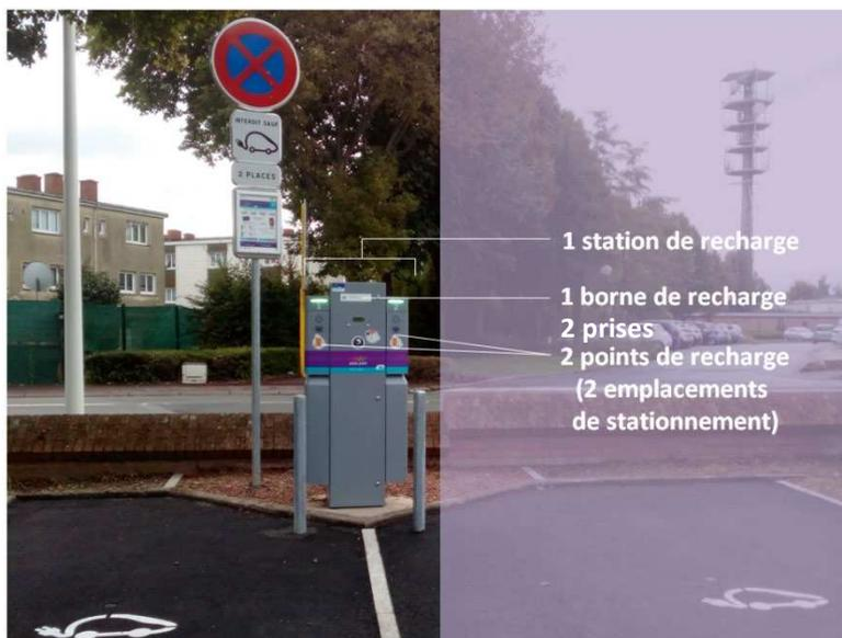
Figure 28 : Configuration d'une station de recharge accessible au public à Douai.
