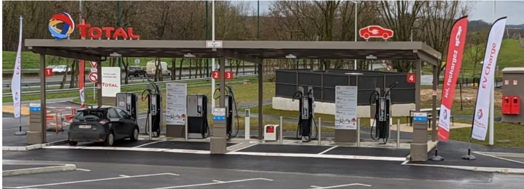
Figure 33 : Station de recharge Total composée de 6 bornes, 14 prises et 4 emplacements de stationnement.
