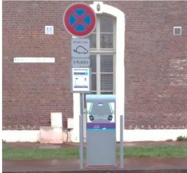
Figure 36 : Borne de recharge à St-Omer (modèle G2Mobility)
