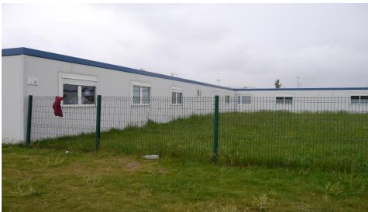
Le modulaire de la permanence d'accès aux soins de santé du centre hospitalier de Calais. ©Chloé Tisserand
