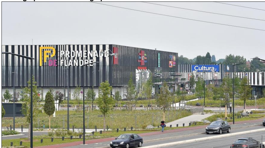
Photographie n°85 : Photographie du centre commercial Promenade de Flandre.
