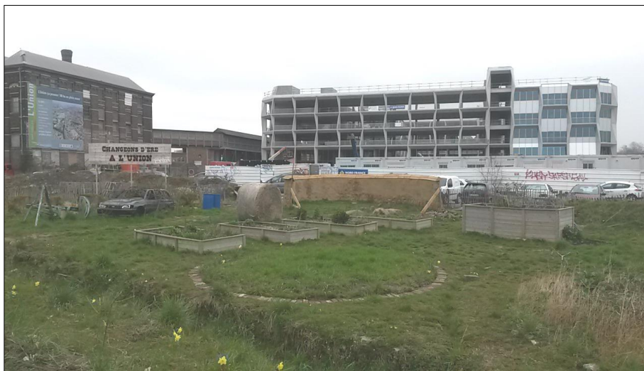
Figure n°95 : Le chantier du parking silo et la ruche d'entreprises de La Tossée se trouvent place à la place et au milieu des friches (octobre 2014).
