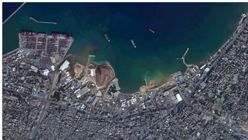
Figure 29: Remblayage en cours, 2016. Source : Google Earth
