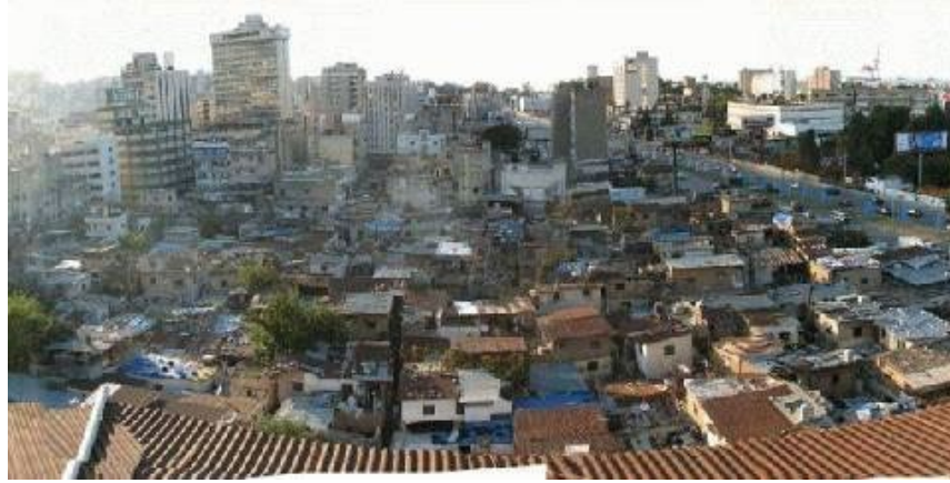
Figure 35: Le camp Sandjak avant sa démolition, Source : Jeunempl, Octobre, 2008 MPLBelgique.wordpress.com https://mplbelgique.wordpress.com/2008/10/11/le-camp-des-refugies-armeniens-a-burj-hammoud-va-etre-demoli/
