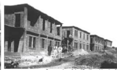
Construction des pavillons blanches
