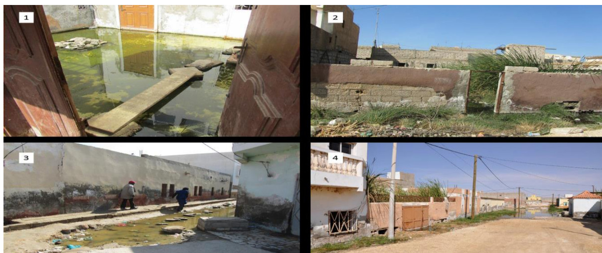
Photo 1. 23: l'affleurement des nappes aggravé parfois par les pluies, a amené les habitants de certains quartiers de Nouakchott, à abandonner leurs maisons (SOCOGIM- ps)
