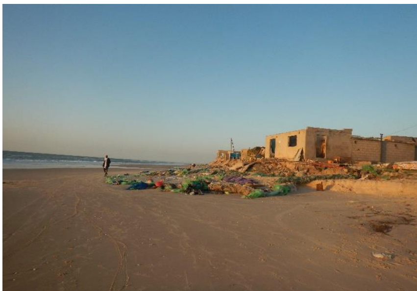
Photo 1. 28: Ville de Ndiago sinistrée par un raz de marée sous l'angle 2
