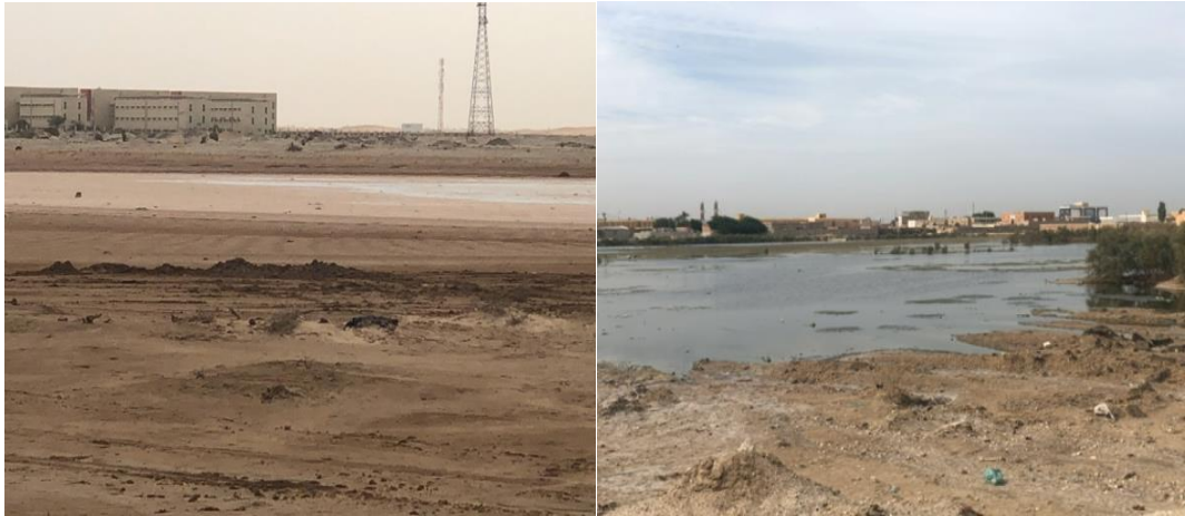
Photo 1. 17: Sols dépressionnaires en banlieue urbaine de Nouakchott, à la moindre goutte de pluie, ils regorgent d'eau menaçant ainsi, toutes les infrastructures urbaines
