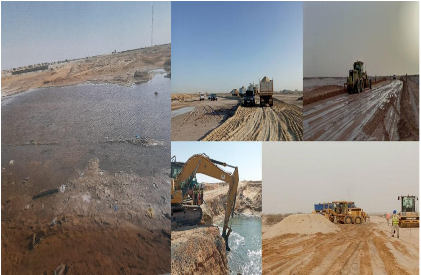
Photo 2. 4: constructions publiques en zone de mares récupérées (extension Université)
