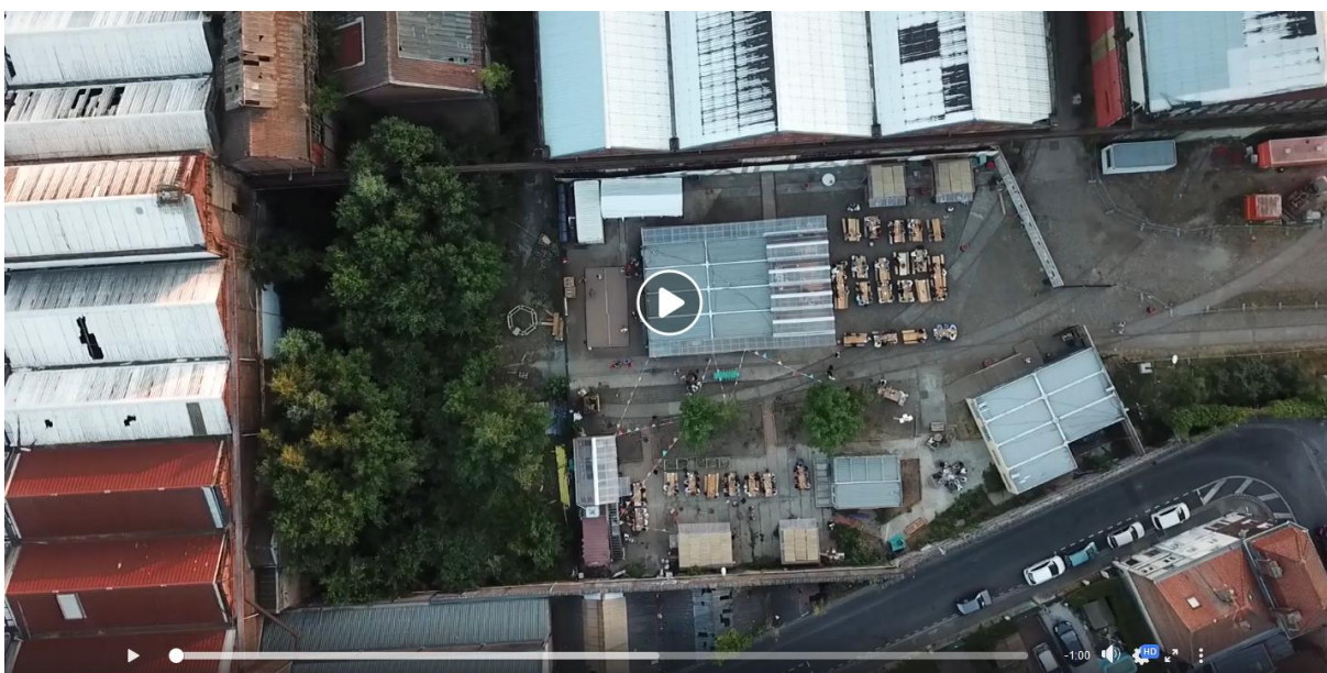
Figure 74 : Vue aérienne du site du projet d'urbanisme transitoire « L'Avant-Goût » avec le food court en activité en 2018 à Lille
