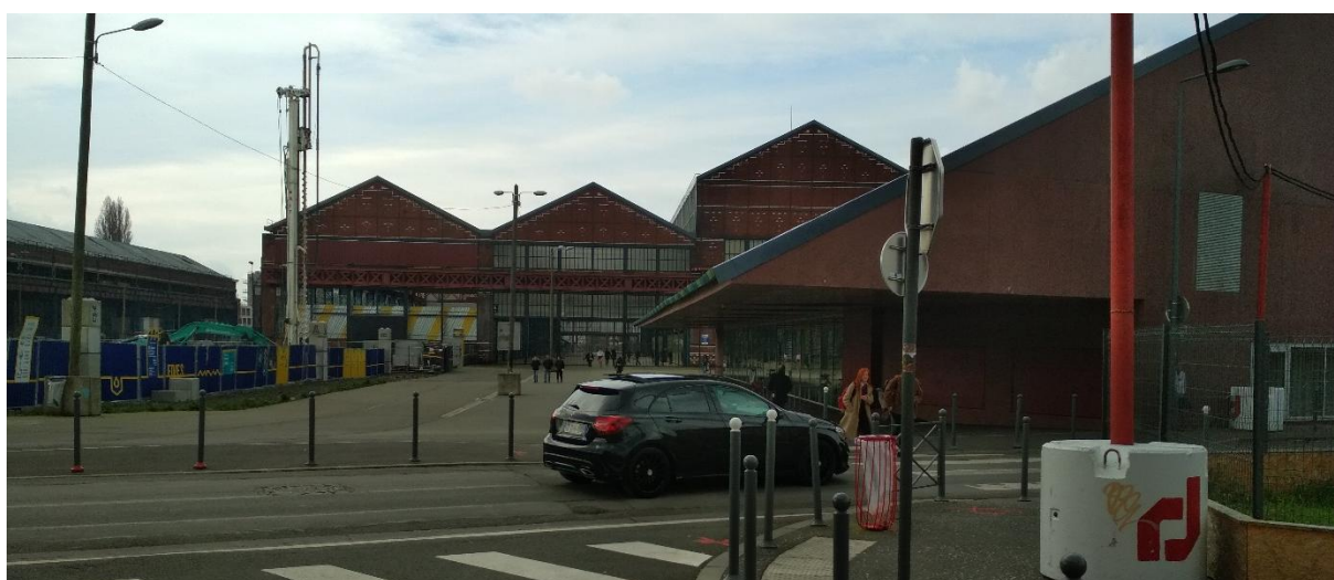
Figure 50 : Vue des halles F6, F7 et F8 (de gauche à droite à l'arrière-plan) depuis la rue A. Ballet à Lille en 2020
