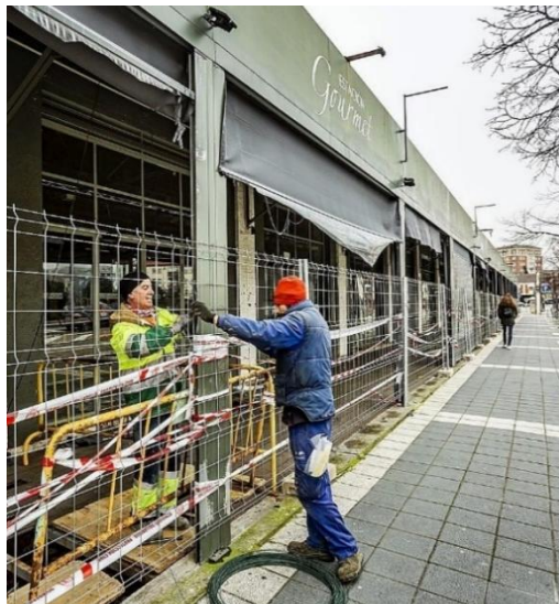
Figure 86 : La halle ayant accueilli le food court Estación Gourmet clôturée par ADIF au début de l'année 2020
