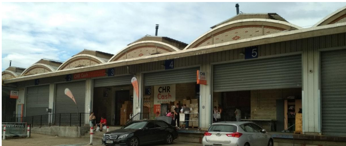
Figure 33 : Un commerce de gros vendant des produits alimentaires en activité en 2021 dans des travées de petites dimensions qui seront démolies pendant la seconde phase du projet urbain Les Messageries
