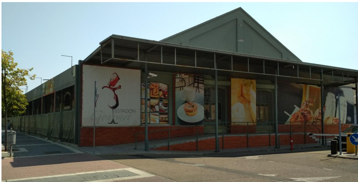
Figure 77 : Présence de photos de plats et de boissons sur la façade principale du food court Estación Gourmet Source : photo de J. Haquet prise le 24 août 2021
