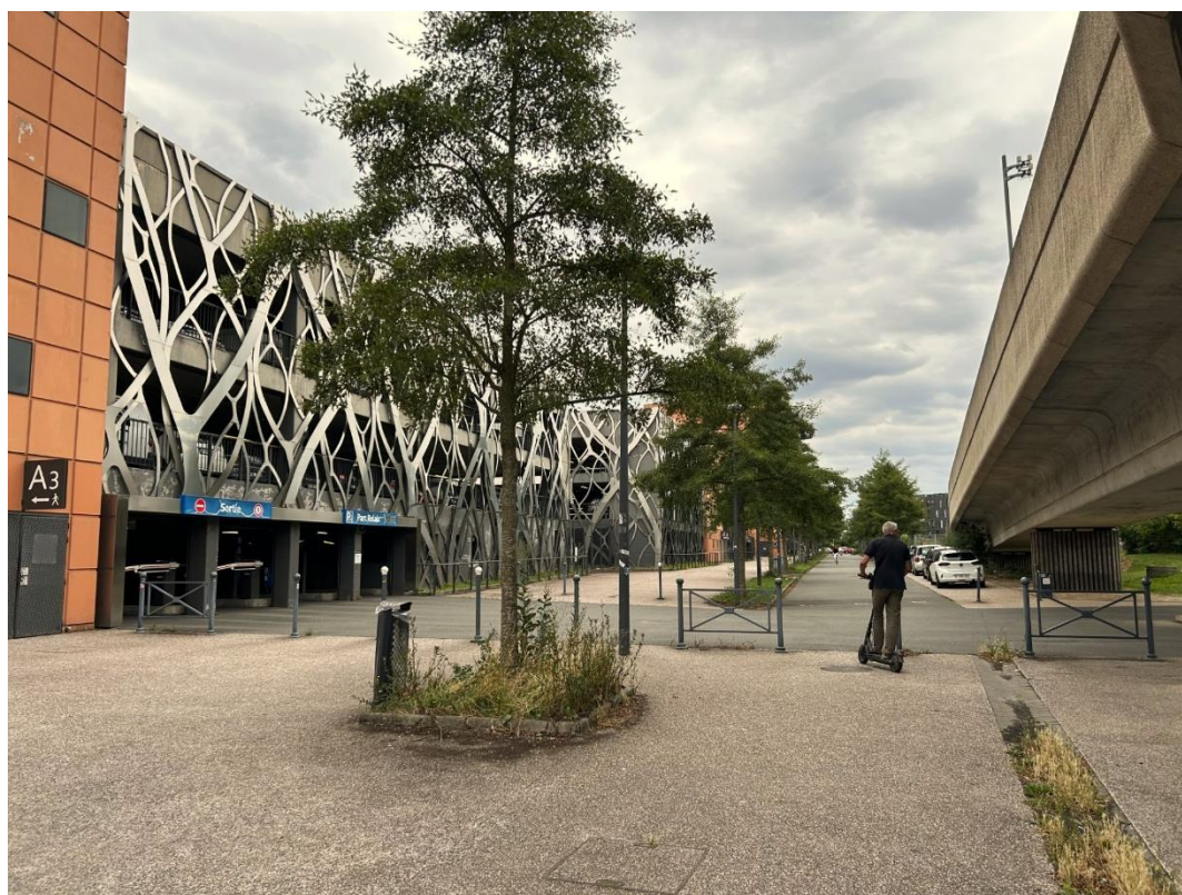
Figure 59 : Les parkings relais en silos face au viaduc du métro à la station 4 Cantons – Stade Pierre Mauroy
