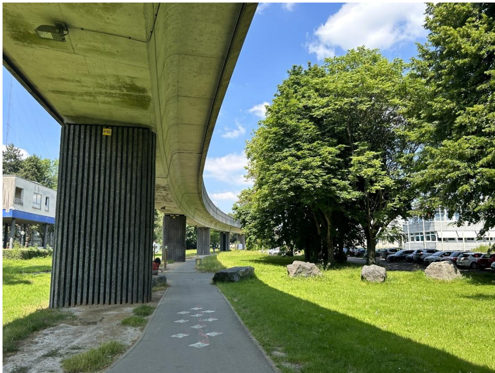
Figure 56 : Le viaduc du métro faisant de l'ombre à une voie piétonne
