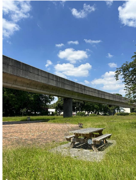
Figure 55 : Le viaduc du métro au-dessus d'une place enherbée devant le bâtiment M1
