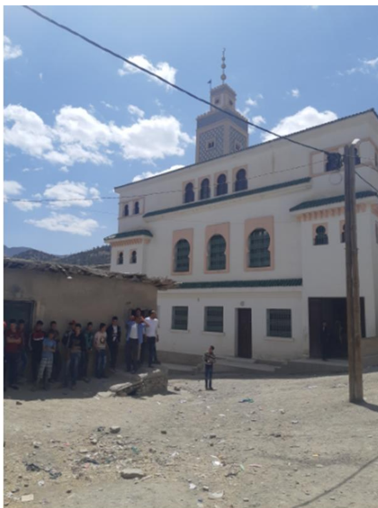
Figure 21 : la mosquée de Tamalout 71
