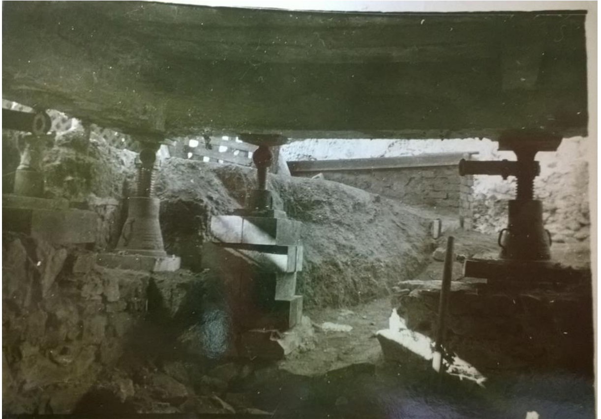
Figure 24 : Système de vérins hydrauliques employés par les Charbonnages d’Hensies-Pommeroeul pour exhausser la cité des Sartis à Hensies, 1934 (Source : SAICOM, CHP , 548).
