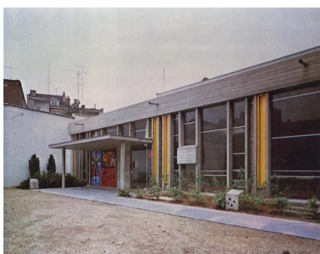
III n° 427 : maison des jeunes d'Anderlecht, façade extérieure
