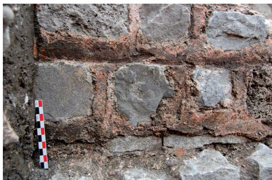
Fig. 11 - Détail des joints en chanfrein du parement extérieur de l'élévation de l'enceinte tardive (V. Merkenbreack / DA 62).
