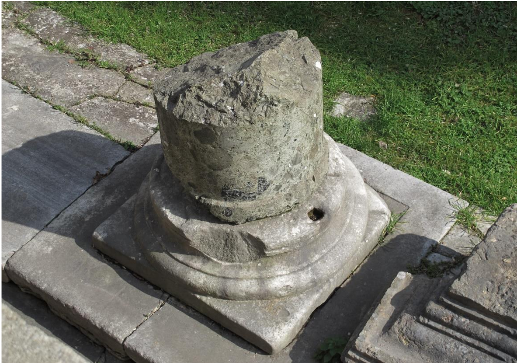
Fig. 51 : détail (stylobate) : vestige de colonne en marbre
