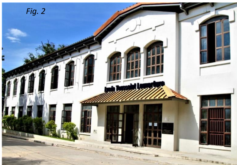
Lycée Toussaint Louverture, Haiti, Source : Ministère de l'Éducation Nationale/Direction du Génie Scolaire
