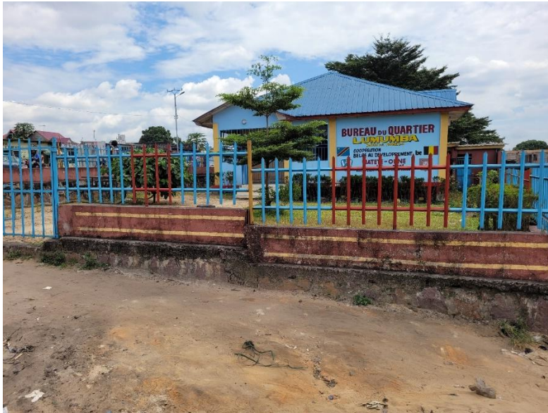
Figure 5 : Le bureau du quartier Lumumba dans la commune de Matete en juin 2021. Ce bâtiment a été construit avec l'aide de la commune de Olne de la Belgique, via une coopération décentralisée entre la commune de Matete et celle de Olne.
