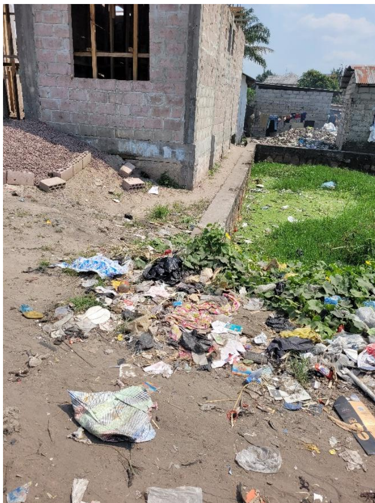
Figure 22 : Une maison en construction dans une ancienne décharges dans le quartier Malemba à Matete. Cette maison est en brique. Le propriétaire a pris confiance après avoir attendu plus de deux ans avant de couler un béton en remblayant de la terre sur une décharge. Photo prise lors de l'enquête de terrain dans le quartier Mbamu à Matete. Kinshasa, 2022.
