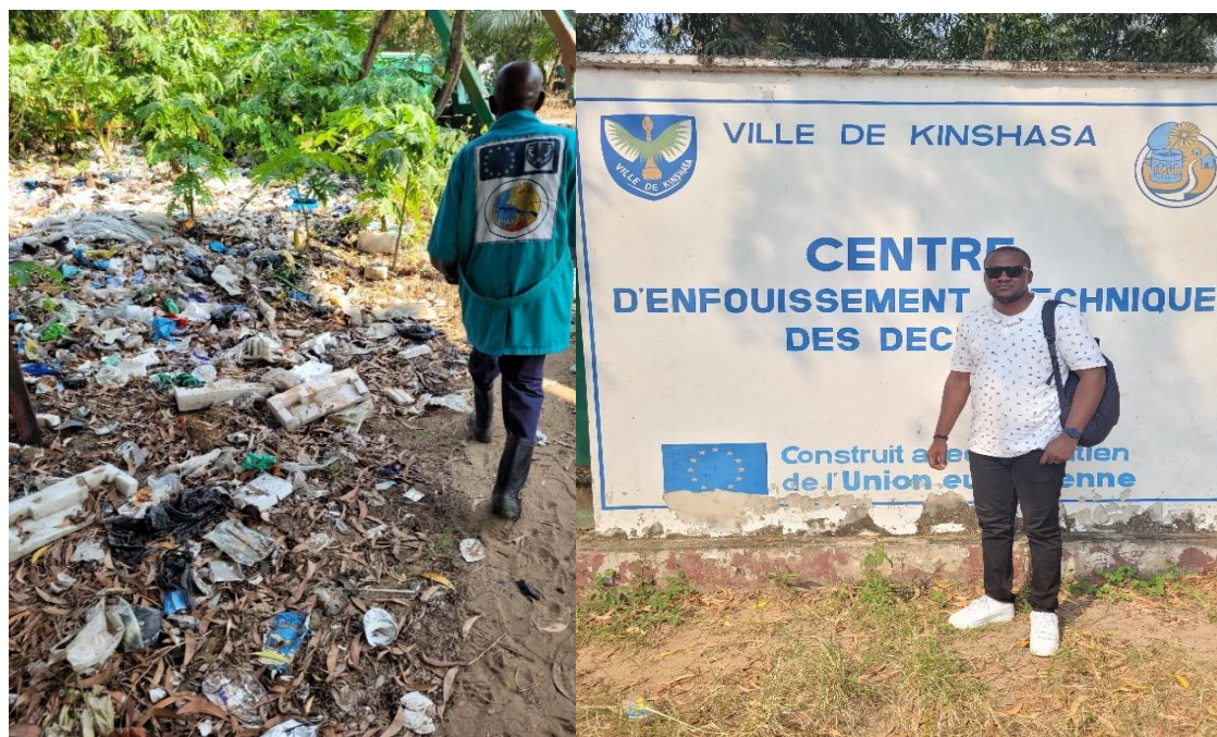
Figure 5 et 6 : Dans cette image, on peut voir l'extérieur et l'intérieur du CET Mpasa en 2022. Rappelons ici que ce centre a été construit en 2010 avec l'aide de l'UE via le FED. On peut voir sur ces images l'état de délabrement du centre. Les déchets sont exposés à même le sol au lieu d'être enfouis faute d'outil, d'équipement et de revitalisation par les autorités urbaines. Enquête au CET de Mpasa à Kinshasa entre juin et juillet 2021.
