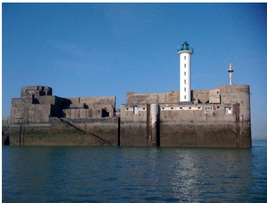
Figure 1-4 : Station de mesure MAREL-Carnot (tube à demi-immérgé au premier plan, en bas à gauche du phare) installée sur la digue Carnot de Boulogne-sur-mer, (Photo F.G. Schmitt).
