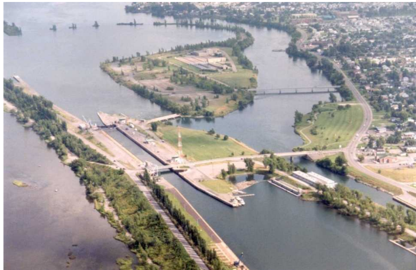
Figure 4.8 Vue aérienne de l'écluse Côte Sainte Catherine
