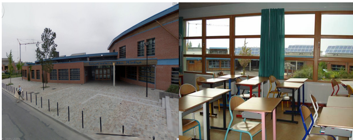
Figure 27 : A gauche, vue extérieure de l'école HQE Jean Mineur, A droite, vue intérieure de la pièce étudiée de l'école HQE Jean Mineur.
