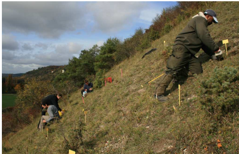
Photo Renforcement de Bn3, le 4 novembre 2010. Photo de Nina Hautekèete
