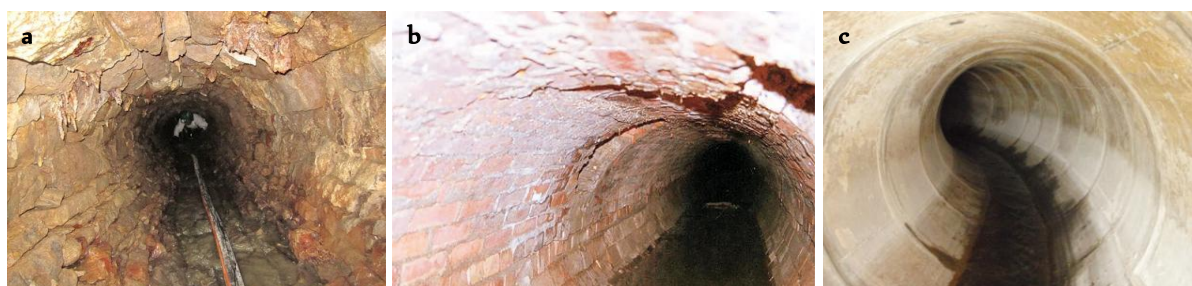
Figure 5 : Photographies de différents types de tuyaux d'égout. a – tuyau d'égout en pierre Texas, USA ; b – tuyau d'égout en brique New York, USA ; c – tuyau d'égout en béton Texas, USA.
