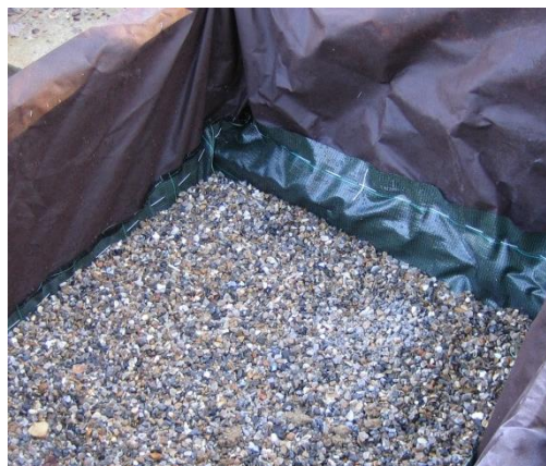
Mise en place du géotextile et du gravier
