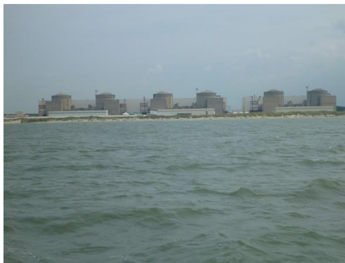
Figure I-26 : Centrale nucléaire de Gravelines vue depuis le large (© Christophe Luczak).
