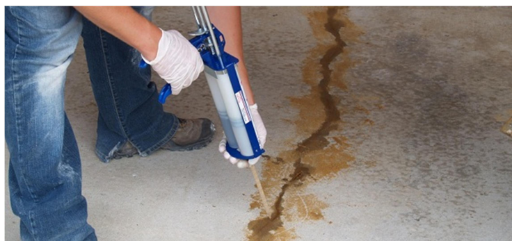
Figure 3 : Application de résine au moyen d'un pistolet (Source : Sika)
