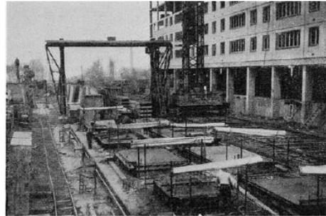
Figure 2 : Préfabrication foraine desservie par portique et grue [Balency, 1964]
