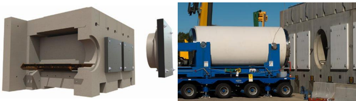
Figure 137 : Haut : Représentation schématique de la coupe d'un module NUHOMS® ; Bas : Photographie de l'introduction d'un canister de combustibles usés dans un système NUHOMS® (Source : Orano TN)
