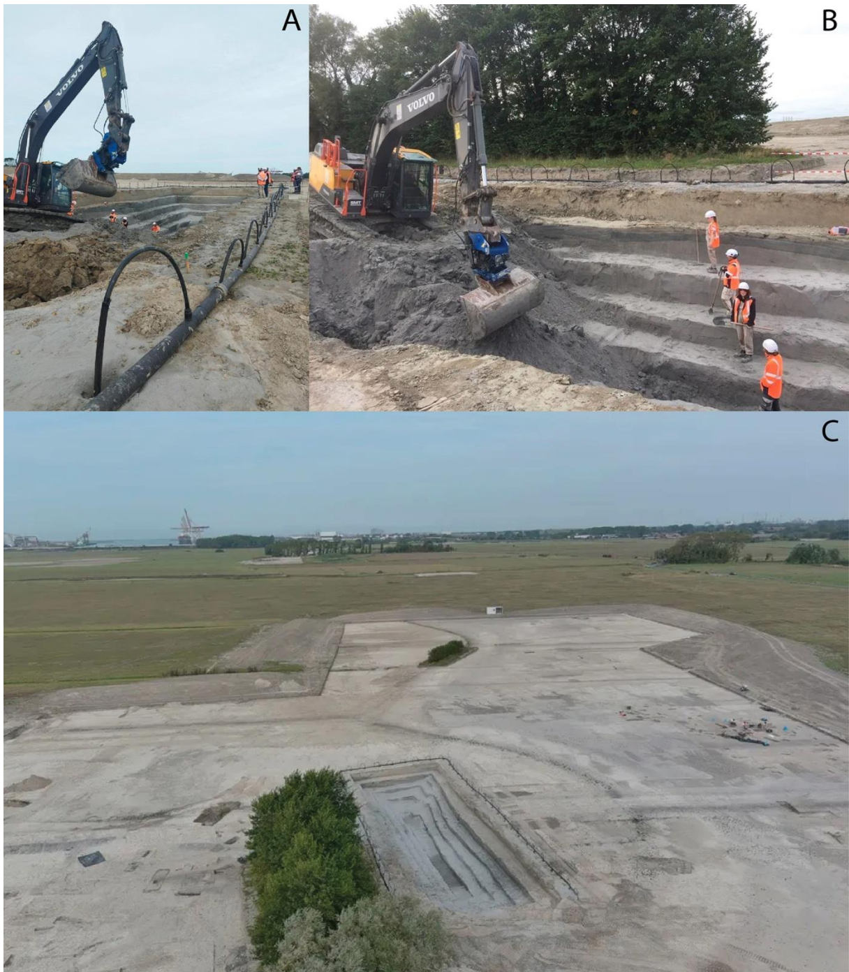
Figure V-30 : Fouille en pyramide inversée réalisé en octobre 2023. A : Dispositif de pompage pour rabattre la nappe phréatique (M. Tyrrell, Inrap). B : Creusement à la pelle mécanique. Les palliers ne forment pas des niveaux archéologiques détaillés séparément mais permettent de descendre la fosse plus profondément sans risque les effondrements (V. Charpentier, Inrap). C : Vue aérienne (drone) de la fosse entièrement creusée (M.Ocadiz, Inrap).
