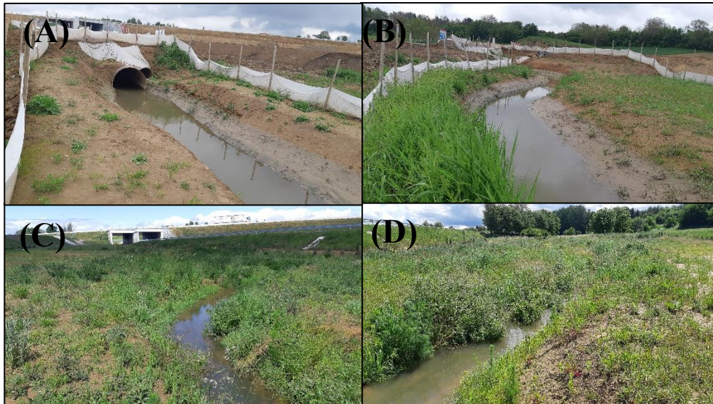
Figure 16. Photographie d'un site échantillonné en 2021 (A, B) et 2022 (C, D). Des busages du cours d'eau étaient visibles en 2021 (A). Des travaux de reméandrage ont été réalisés (B, C, D).
