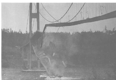
FIG. 1.1 – Effondrement du pont de Tacoma [Smi74]
