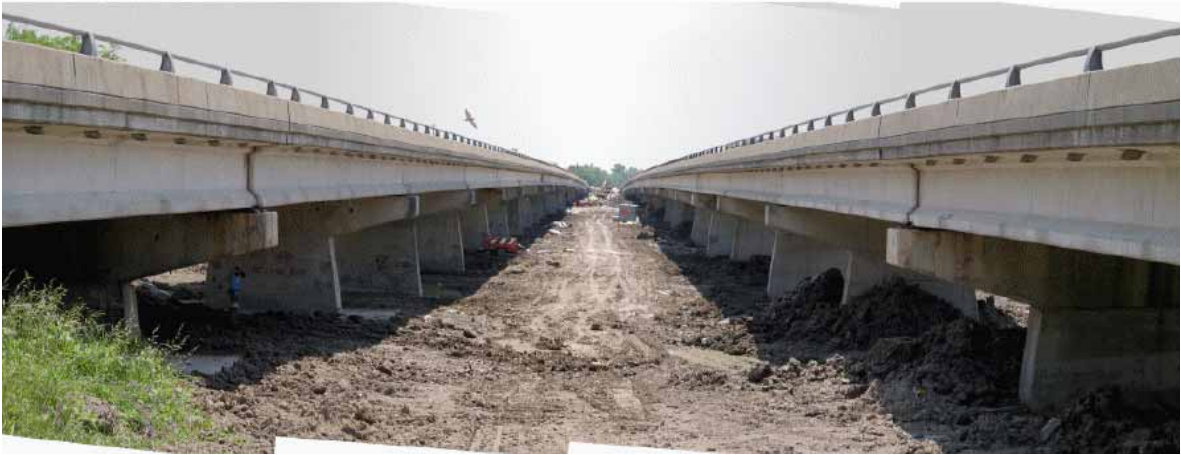
Figure 1.28. Vue globale du pont étudié sur l'autoroute 57
