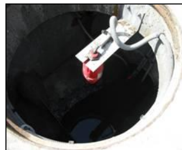
Figure 106 : déversoir triangulaire à paroi mince en aval de la BI
