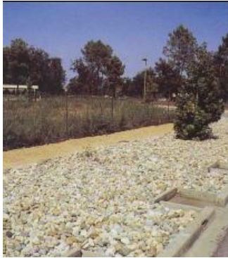
Tranchée sous-trottoir Av de la Grande Lande - GRADIGNAN Source CETE du Sud-Ouest.
