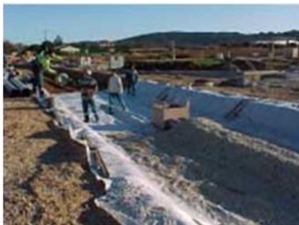
Figure 7 : Mise en place de géotextile pour une chaussée réservoir
