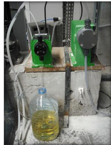
Figure 45 : Injection d'huile de Colza par la pompe doseuse
