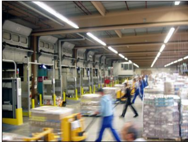
FIGURE 2.15 – Portiques RFID dans un entrepôt logistique
