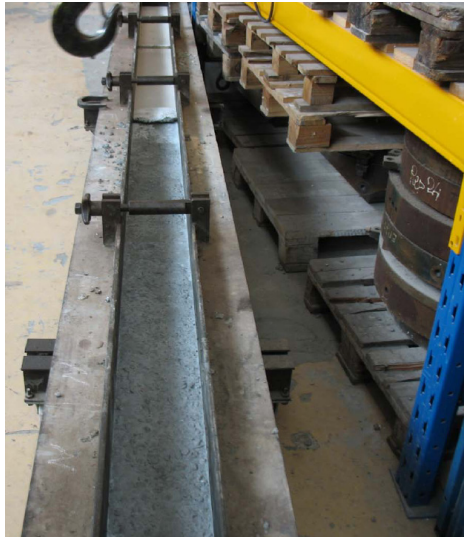
Figure 2.1 : Photo du coulage des poutres.
