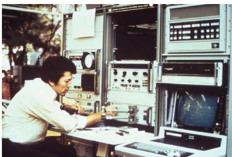
Figure I.3 : L'analyseur de réseaux automatique HP 8542
