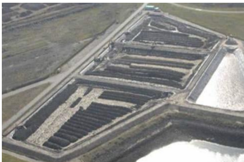
Figure 21: Trois bassins de décantation au GPMD
