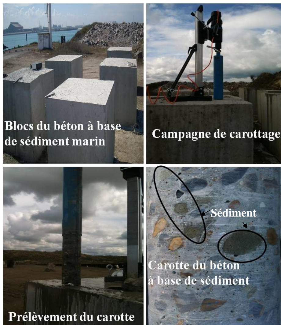
Figure 53: Campagne de carottage sur deux blocs de béton intégrant 12,5% et 20% du sédiment marin
