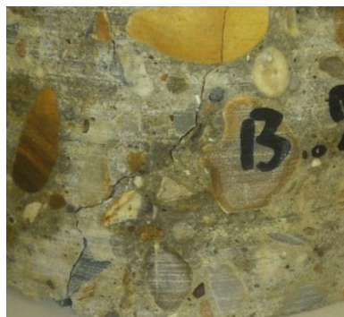
Figure 103: Fissuration du béton B2 après 3 semaines de cycles immersion/séchage à 105°C
