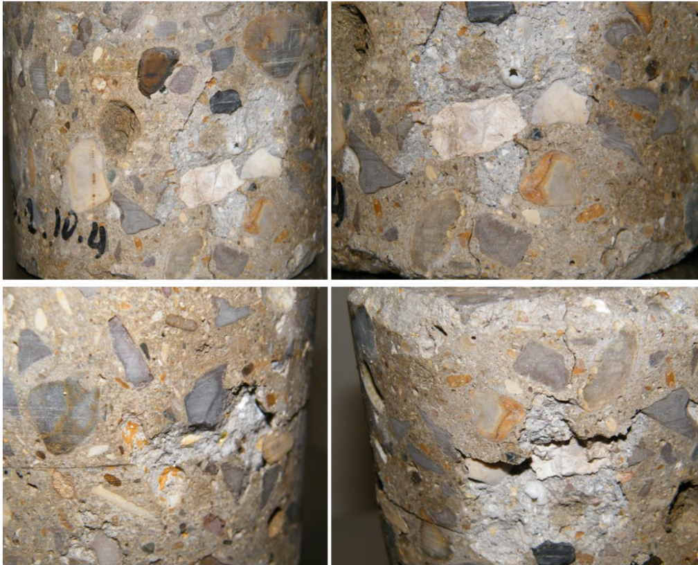
Figure 104: Dégradation du béton B1 après quatre mois de cycles immersion/séchage à 105°C
