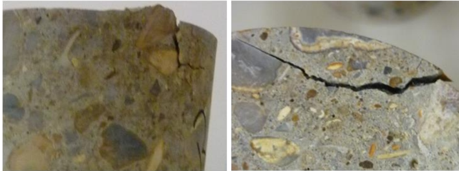
Figure 102: Détérioration des arrêtes du B1 après 4 semaines de cycles immersion/séchage à 105°C
