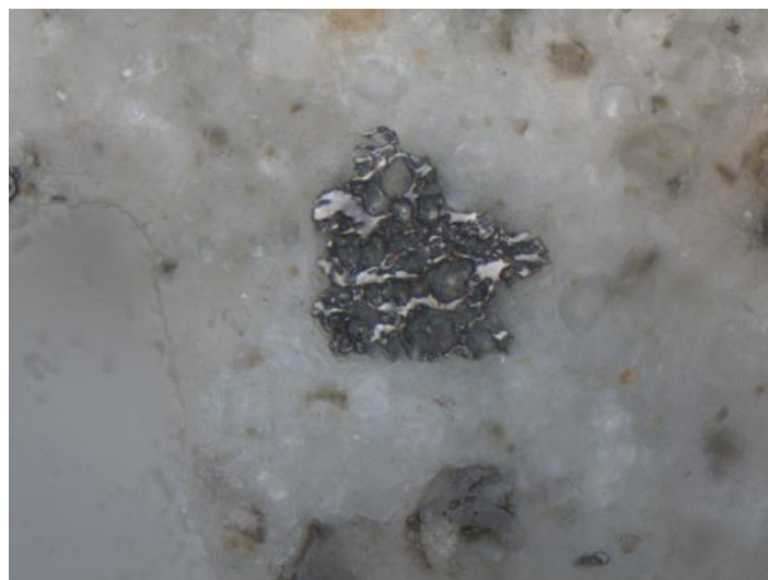
Figure 89: Grain de clinker Portland partiellement hydraté dans le béton B2
