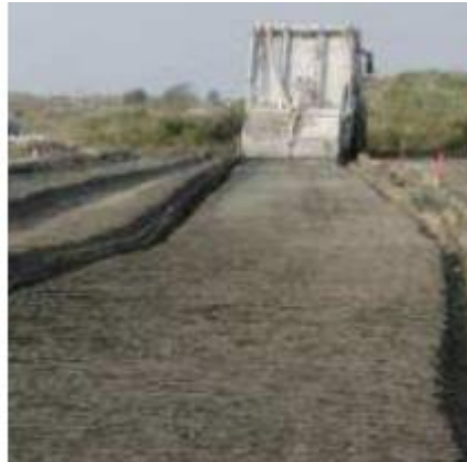
Figure 14: Réalisation d'une planche expérimentale au GPMD en 2005 [Dubois, V., 2006]
