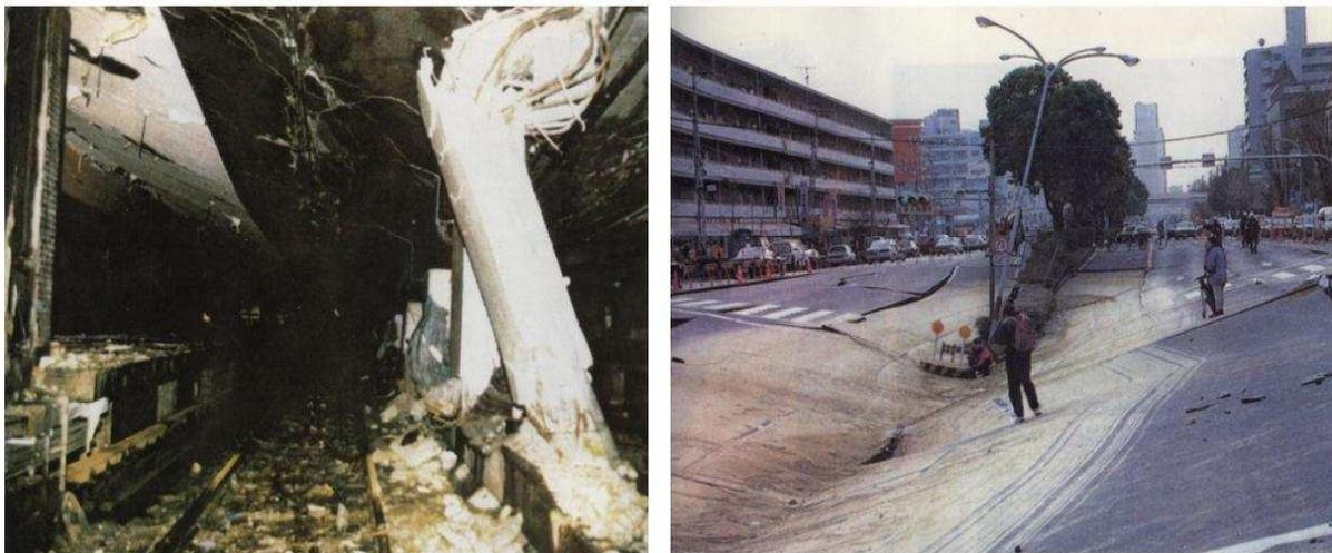
**Figure I.2.** Représentation des dégâts sur une section courante de la station de Métro de Daikai après le Tremblement de Terre de 1995 Hyogo-ken Nanbu (Liu et Liu, 2008).
