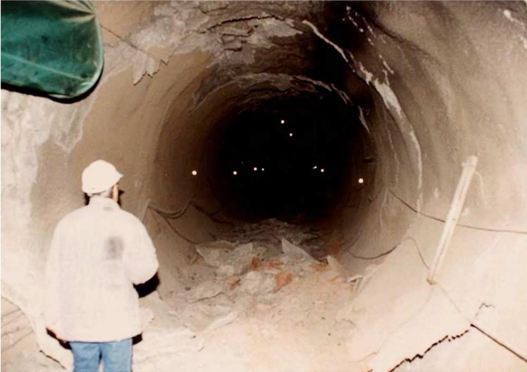
**Figure I.3.** Dégâts occasionnés sur le tunnel pilote du projet du tunnel bi-tubes de Bolu lors du séisme de Düzce – 1999.
