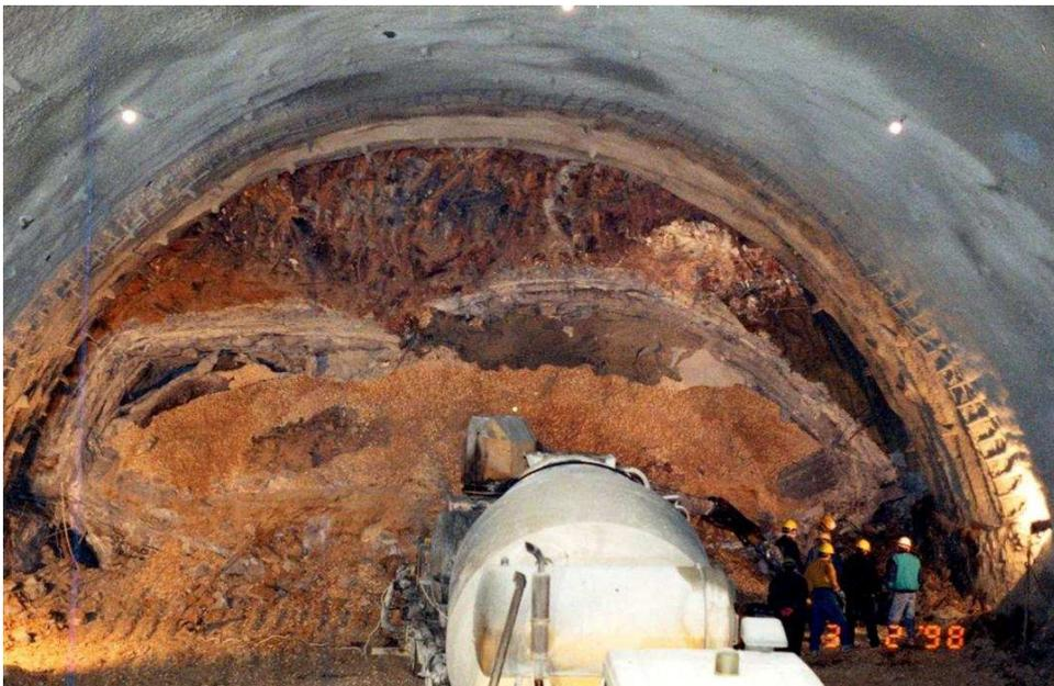
**Figure I.4.** Effondrement du Tunnel de Bolu en Turquie 1999.
