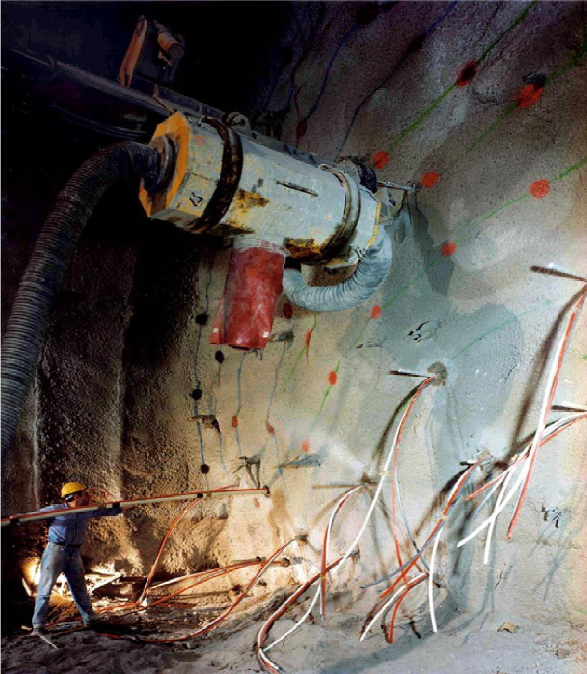
**Figure III.2.** Pose de boulons en fibre de verre au front de taille - tunnel de S. Vitale 1993 – Italie.
