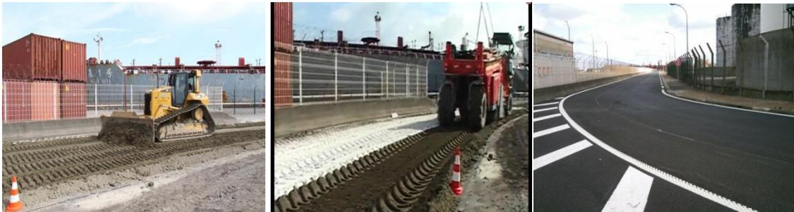
Figure 1.11 : Mise en œuvre de la route du Freycinet 12 à base de sédiments de dragage du GPMD
