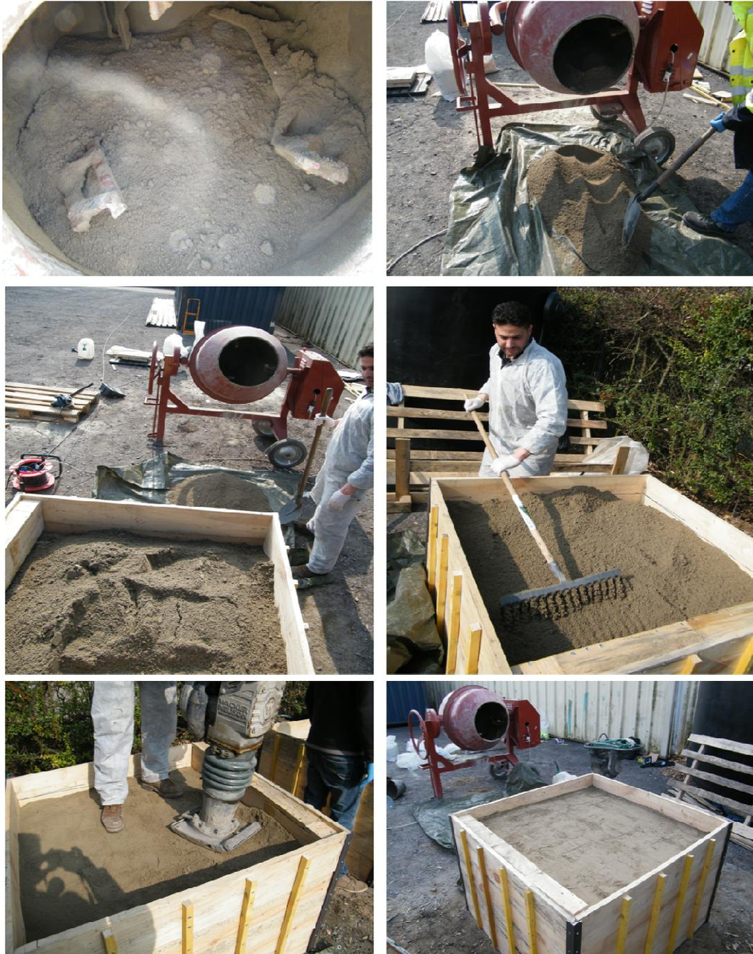
**Figure 4.34 :** Procédé de réalisation de la planche expérimentale à base des sédiments de la Belgique.
